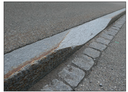
Abb. 2: Randsteinabschrägung können entscheidend zur Reduktion von Tierverslusten auf Strassen beitragen.
