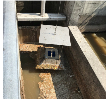
Abb. 7: Schwimmende Amphibienrettungsstation im Fettabscheider, entwickelt durch die ARA Au St.Gallen. (J. Barandun)
