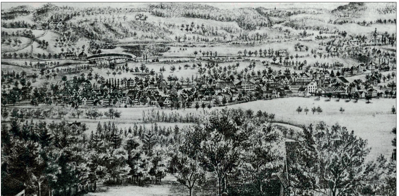
Abb. 8: Blick von Uzwil nach Oberbüren um 1860 (Staatsarchiv, ZMH79/001)
