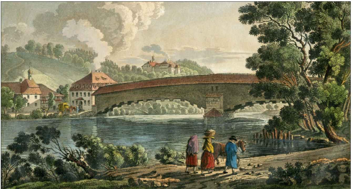
Abb. 4: Brücke bei Oberbüren mit Glattburg 1825 (Staaatsarchiv St.Gallen, ZMH51/004a)
