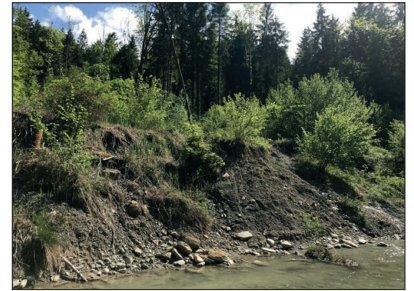
Instabile Uferböschungen aus alten Flussablagerungen rutschen bei Hochwasser ständig nach.
